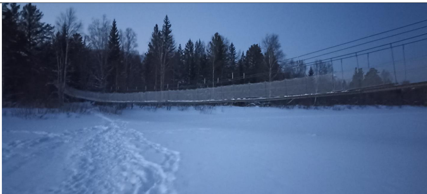
Рисунок 37 Мост над замёрзшей р.Юрюзань.
